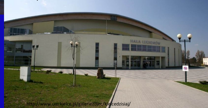
Budowa wielofunkcyjnej hali sportowej w Kielcach, ul. Boczna 15;
